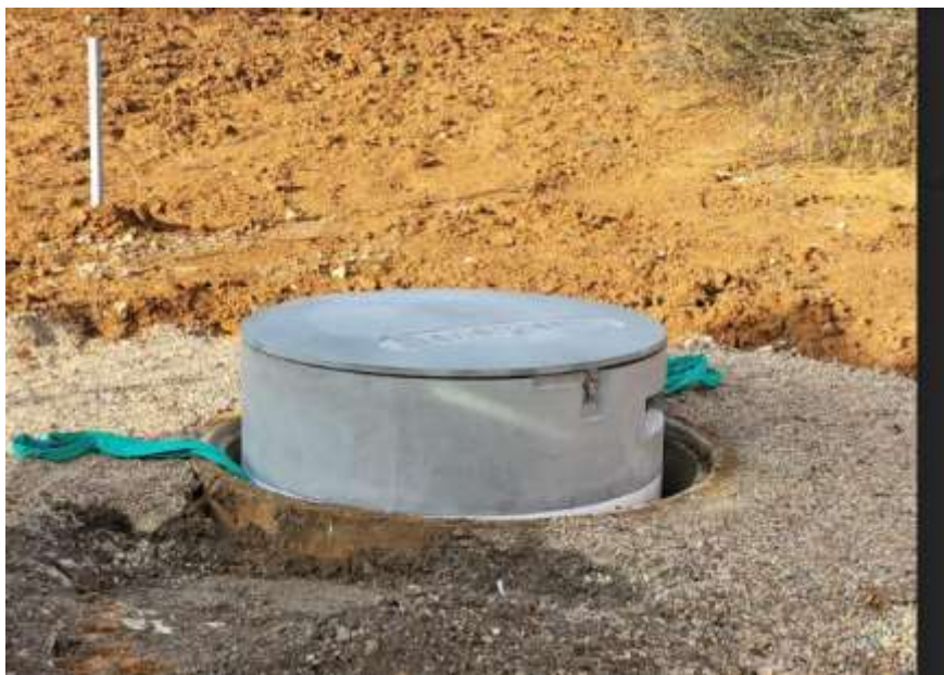
Figure 10: volant à inertie en cours de déploiement pour stocker l'énergie solaire de jour et l'utiliser la nuit pour faire de l'éclairage municipal
