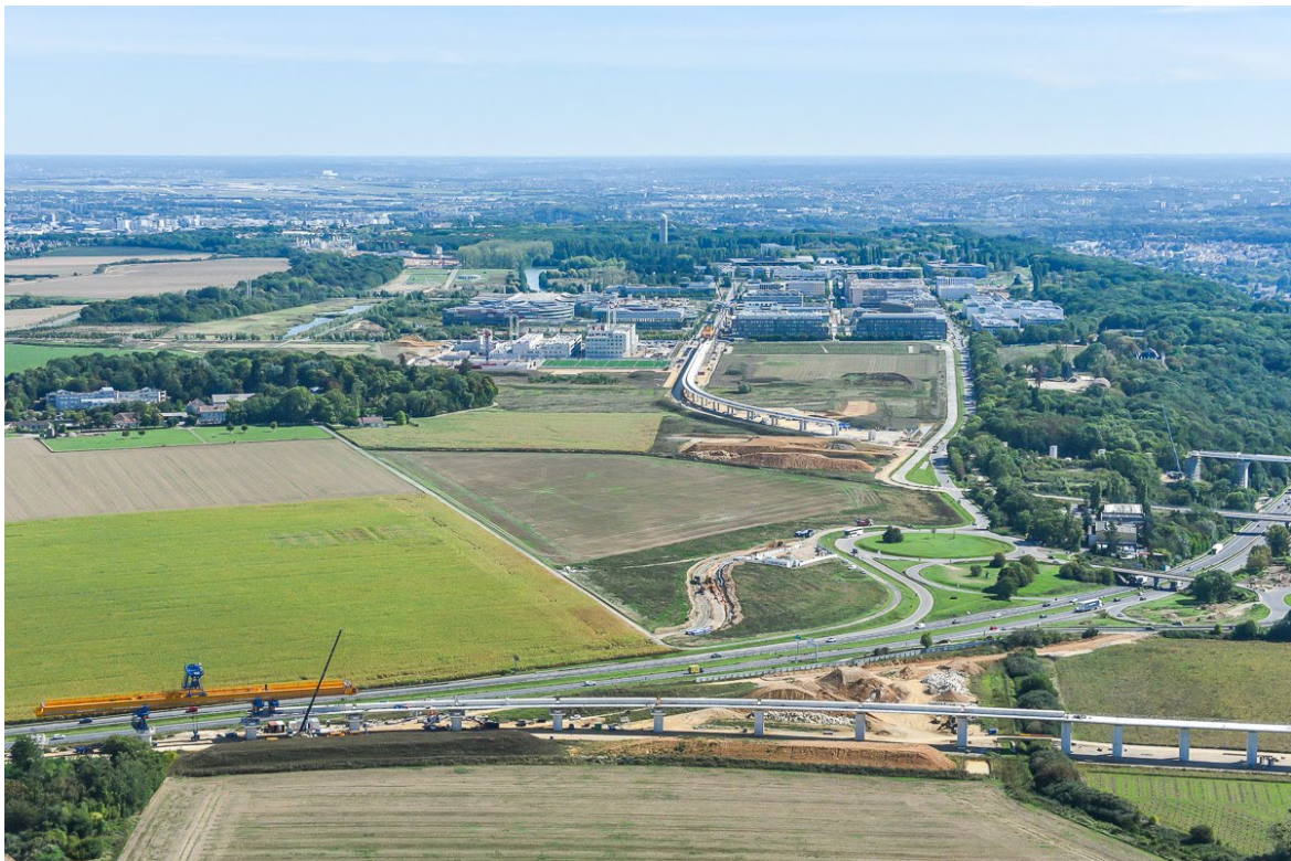
Vue aérienne (2022) de la ZAC, depuis l'ouest. (@Alticlic - EPA Paris-Saclay, sept. 2022) Au premier plan, le viaduc de la L18 et l'échangeur de Corbeville
