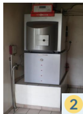
Réhausse de chaudière
