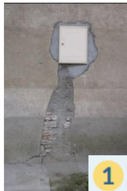
Rehausse du compteur électrique
