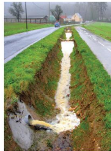
Fossé à redents, Forges-les-Bains
