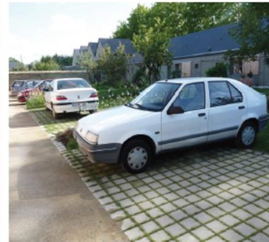
Stationnement perméable, Bouvron (44)
