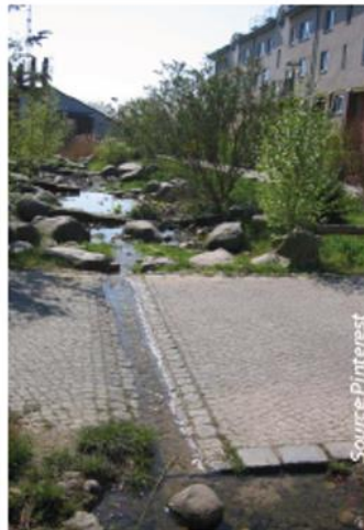
Noüe traversant une chaussée
