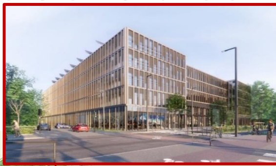
Centre de recherche Danone Livraison : T3 2022
