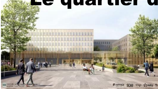
Hôpital Paris-Saclay (GHNE) Démarrage chantier : 2021 Mise en service : 2024
