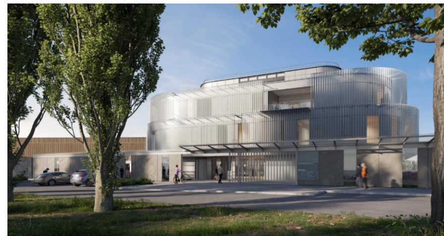
Centre d'exploitation L.18 – SGP JSF
