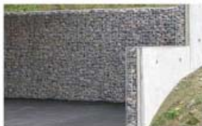
Figure 22: Exemple d'écran en pierre pouvant accepter des matériaux absorbants de façon à limiter la propagation acoustique.
