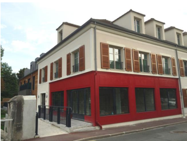
Exigüité du trottoir rue de la République
